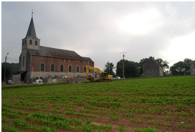
Fig. 2 : Vue générale de l'intervention
