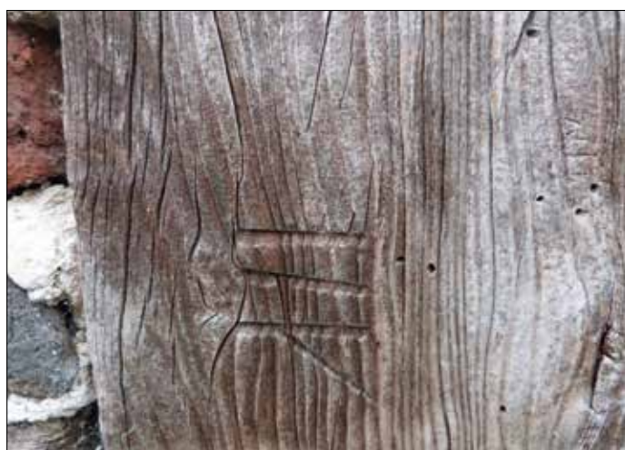
N°6 Bormenville, marque de charpentier, détail.
