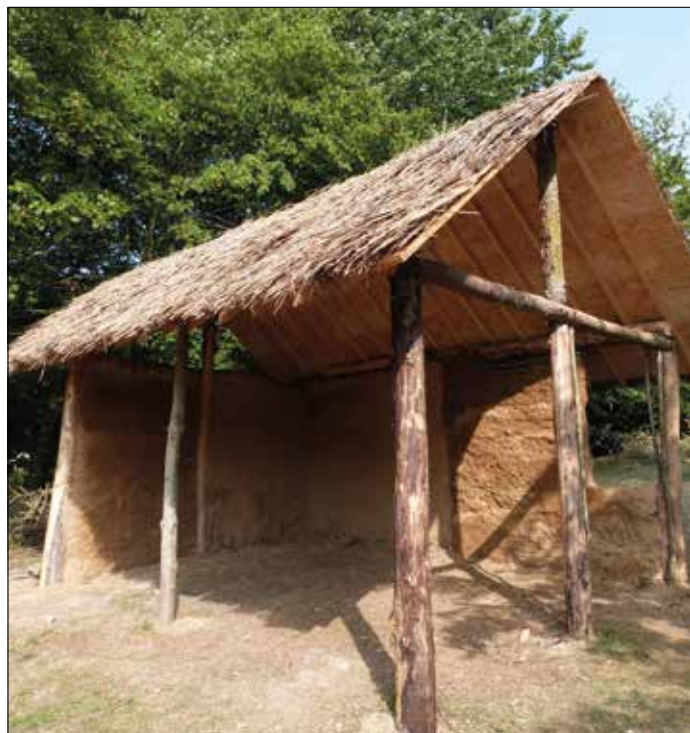
Aspect final du bâtiment en torchis
