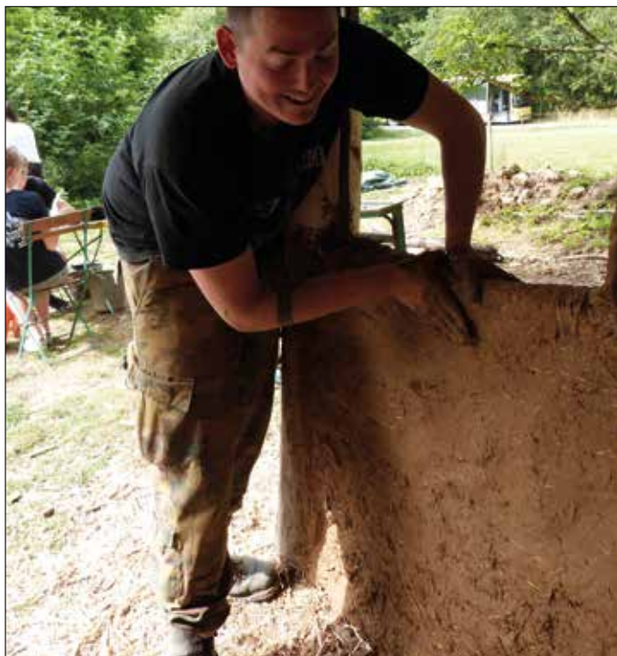
Montage d'un hourdis en torchis en utilisant la technique (2)
