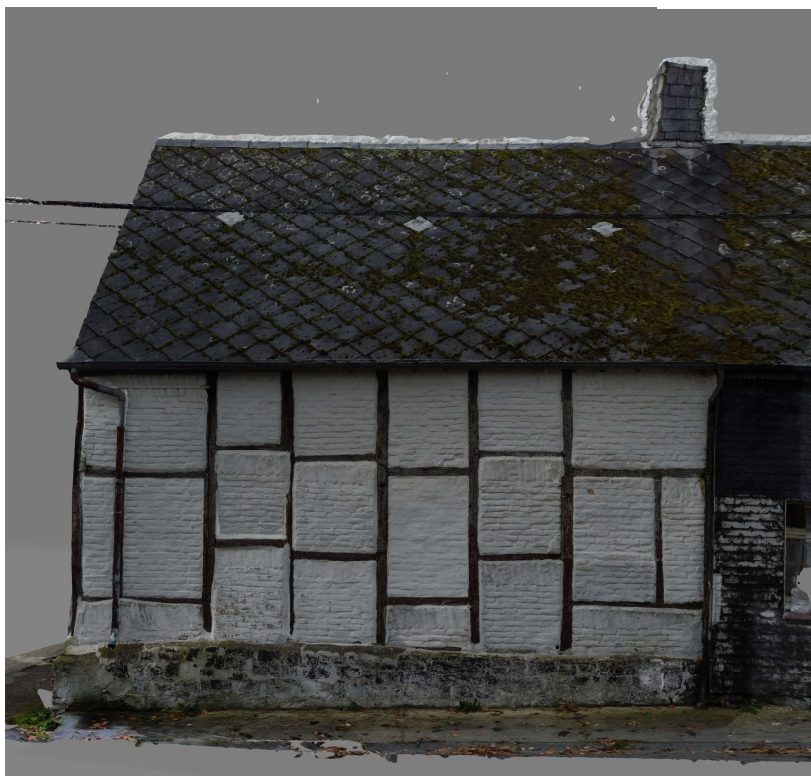
Figure 2 Vue par photogrammétrie du mur gouttereau d'une maison à Havelange (J. Denet)
