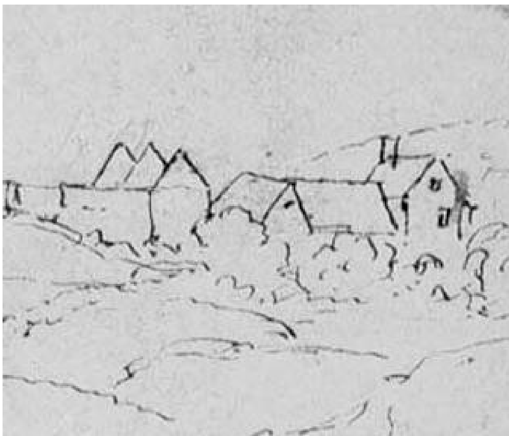
Figure 14 Englebert Fisen, début 18e s. Détail d'une vue du château d'Haltinne. A gauche, la cense de Leschy, à l'état de ruine. A droite, le volume élevé du logis du presbytère. Tous les dessins de Fisen ont été publiés dans TOURNEUR 2019.
