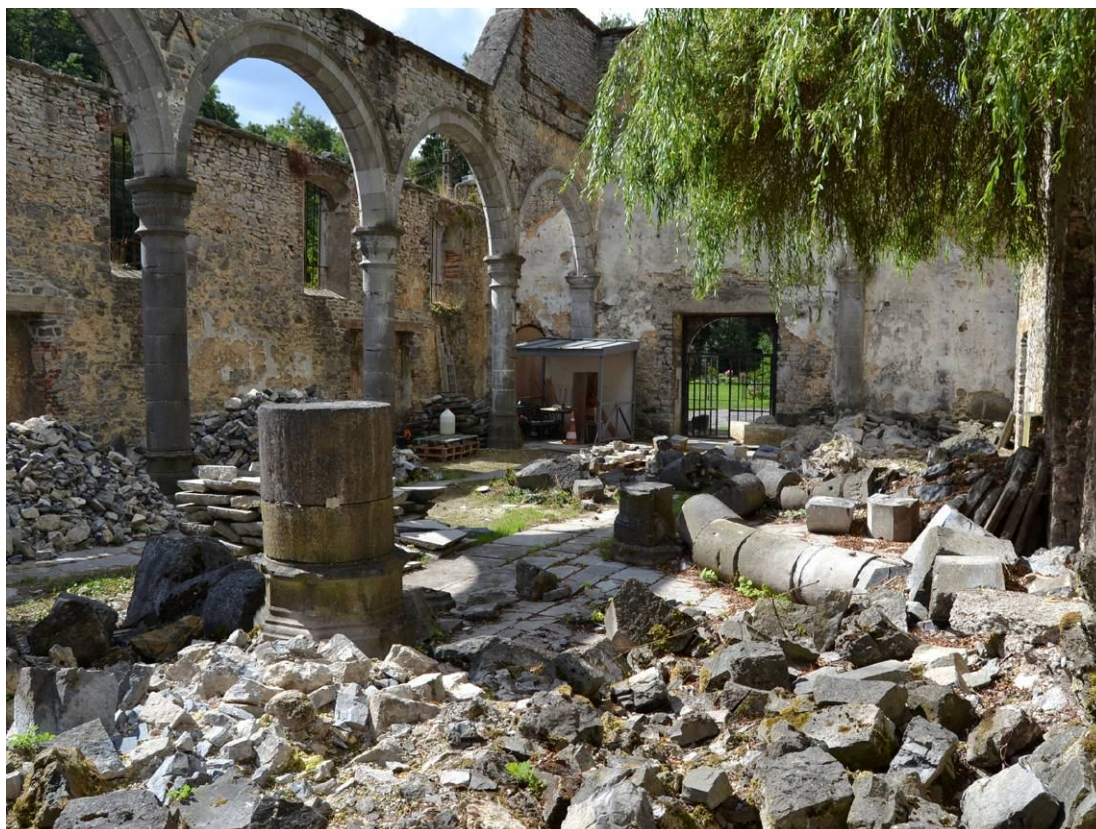
Fig.2 Vue intérieure de l'édifice. On peut y observer, d'une part, la colonnade encore en élévation et, d'autre part, l'effondrement de la seconde colonnade
