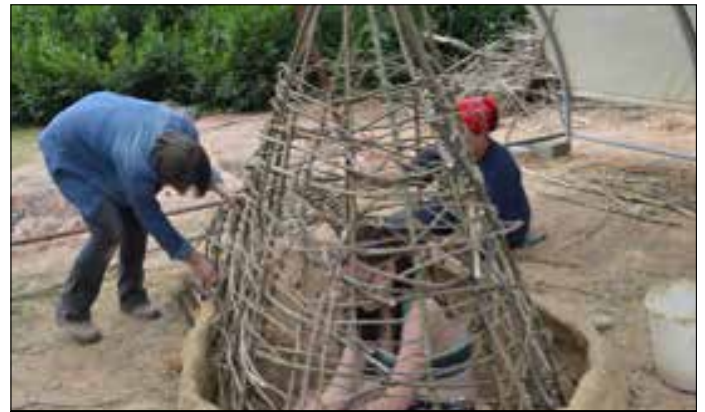
Enduisage du panier avec des briquettes d'argile crue
