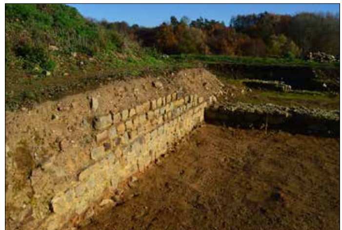
Ressaut du mur oriental de la salle centrale
